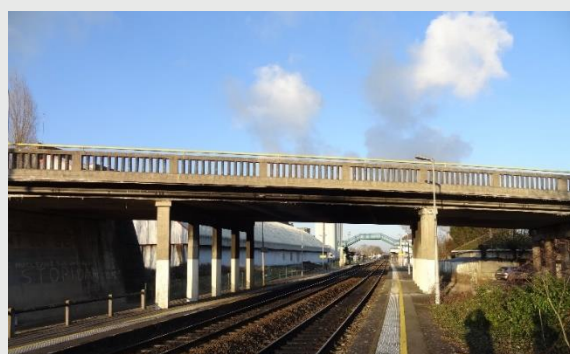
Le pont-route à démolir en gare de Nogent-sur-Seine
