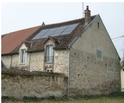
Panneau photovoltaïque en verrière à l'opposé de la rue
